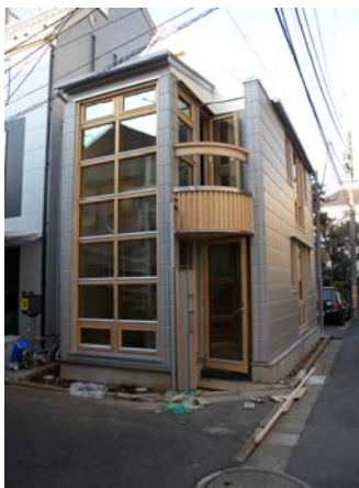
狭小住宅の外観（大きな南面窓）
